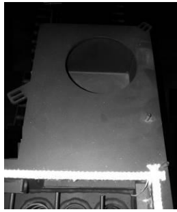
Figura 58 – Retirar os parafusos do extractor e aspirar a zona de passagem do ar.
