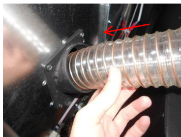
Figura 49 – Colocación del silo cerca de la caldera (a); conexión del silo al depósito de la caldera (b e c)
