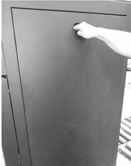
Figura 14 – remoção das capas laterais
